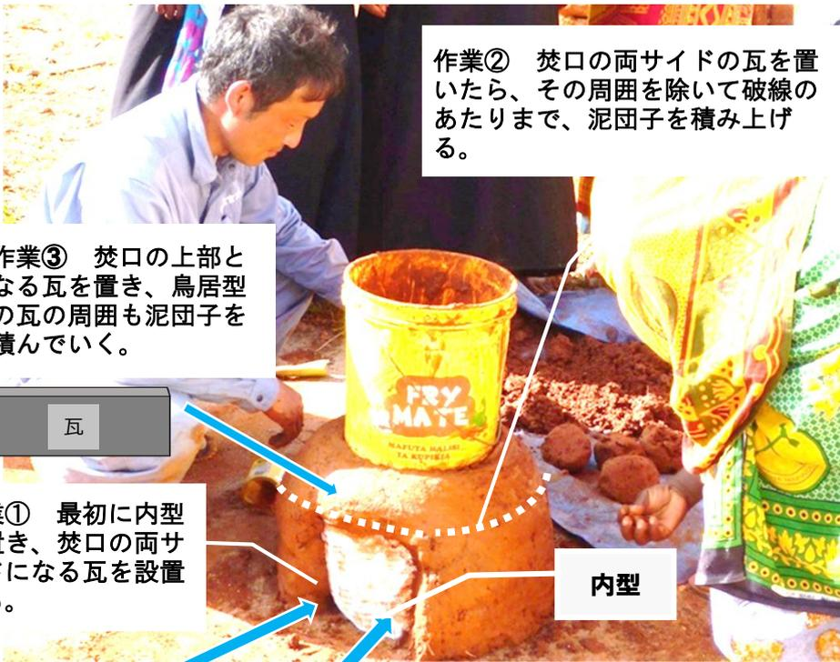
作業② 焚口の両サイドの瓦を置いたら、その周囲を除いて破線のあたりまで、泥団子を積み上げる。
